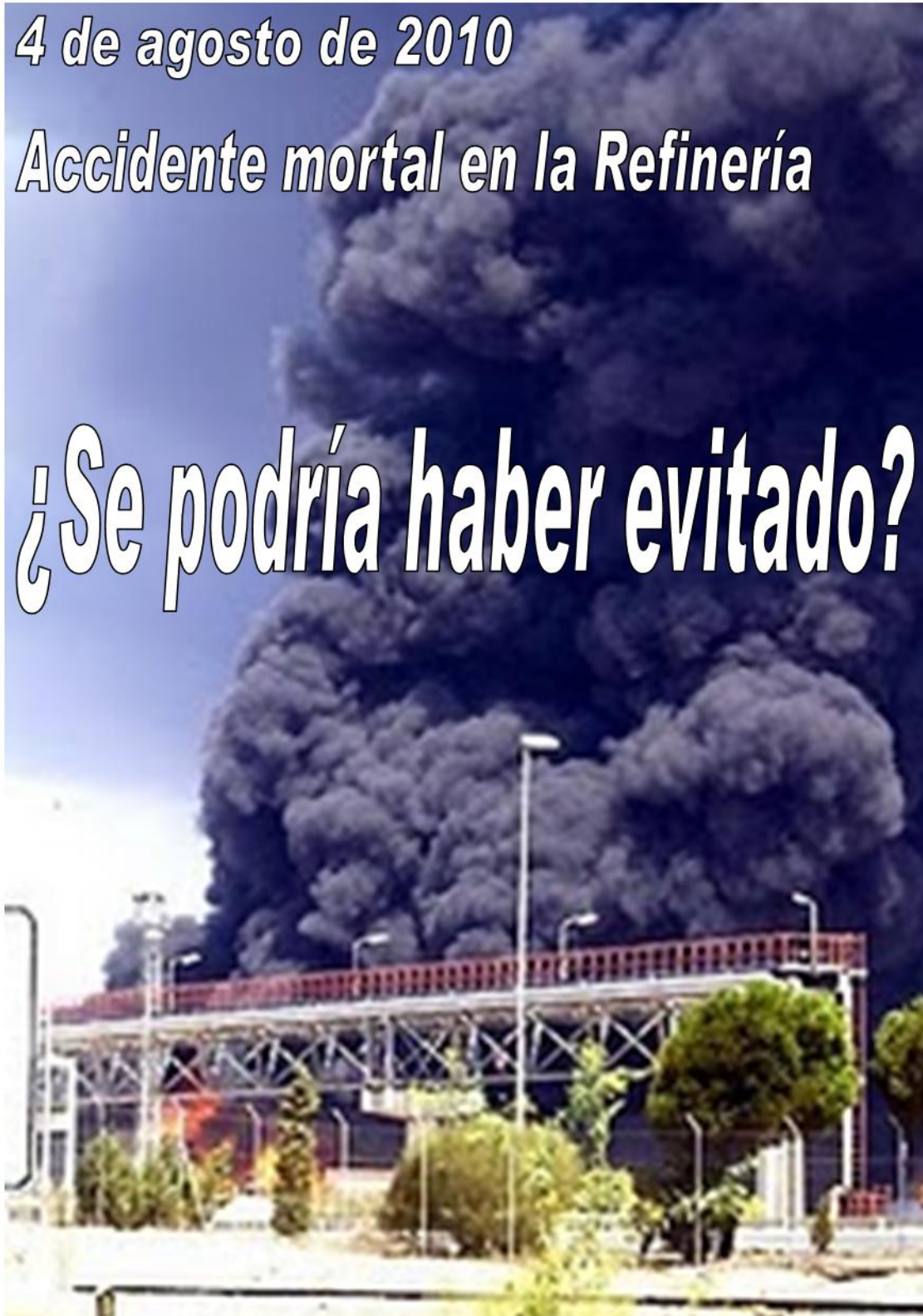
Explosión e incendio en CEPSA Refinería La Rábida el pasado 4 de agosto de 2010
